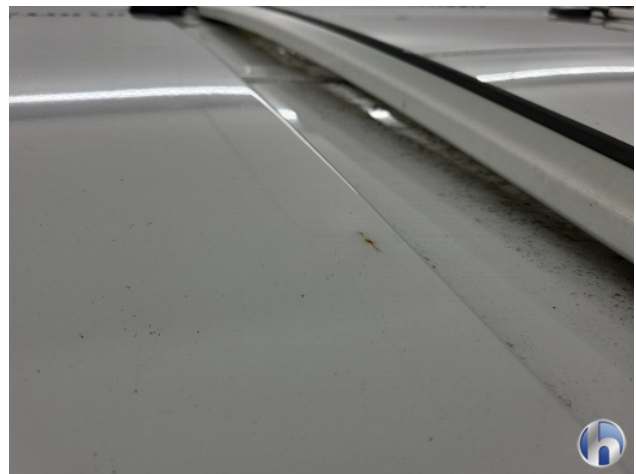
3. Dak Deuk/deuken - Herstellen
