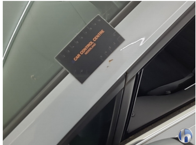
1. Dakframe - links Krassen - Aanvaardbaar
