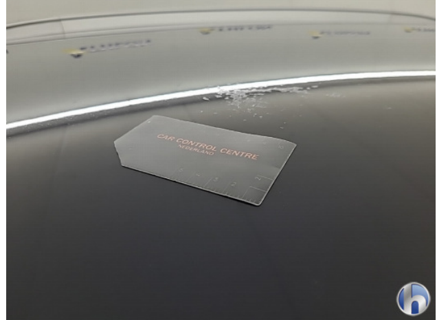
1. Dak Gebruikssporen - Aanvaardbaar
