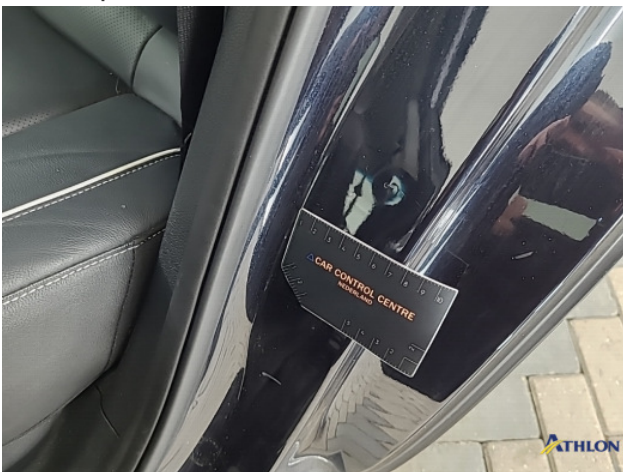
2. diverse schades Gebruikssporen
