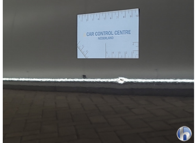
1. diverse Gebruikssporen - Aanvaardbaar
