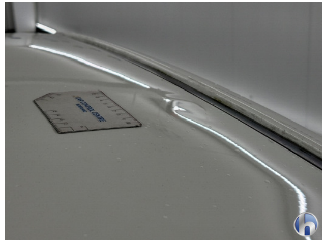
3. Dak Deuk/deuken - Herstellen zonder spuiten
