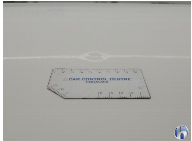
1. Dak Hagelschade - Herstellen zonder spuiten
