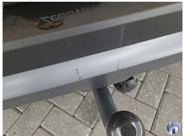
1. diverse Gebruikssporen - Aanvaardbaar
