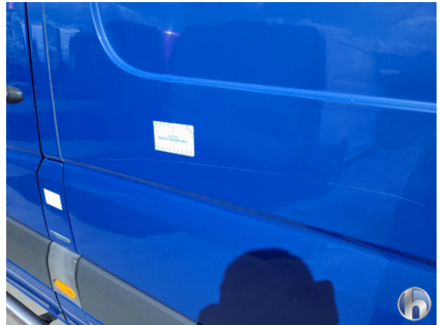
1. diverse Gebruikssporen - Aanvaardbaar
