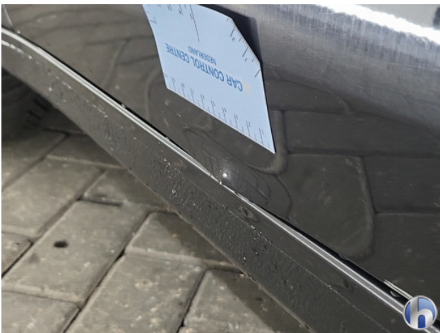
1. Portier voor - links Gedeukt - Herstellen
