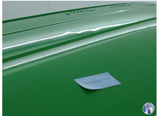
1. Dak Gebruikssporen - Aanvaardbaar
