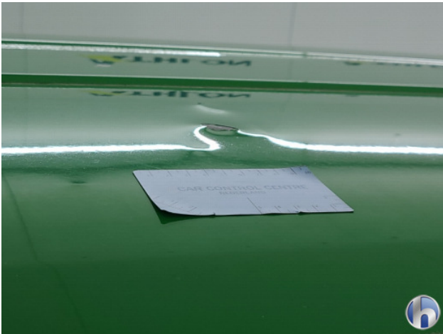
1. Dak Gebruikssporen - Aanvaardbaar
