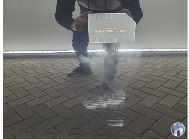
1. diverse schades Gebruikssporen - Aanvaardbaar
