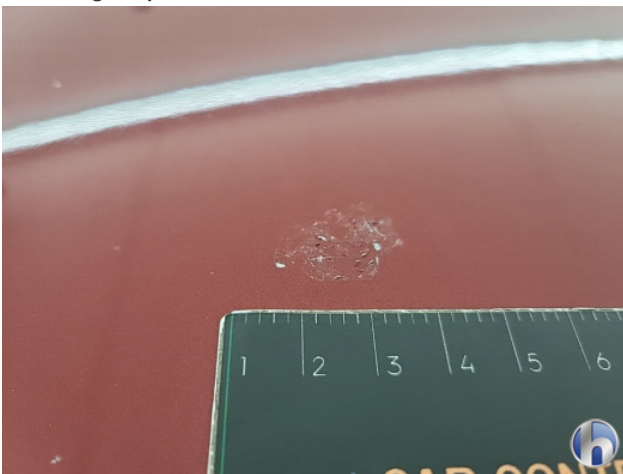
2. lakonthechting Beschadigd - Spuiten
