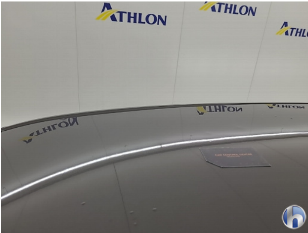
1. Diverse Gebruikssporen - Aanvaardbaar
