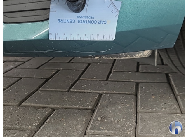
1. diverse Gebruikssporen - Aanvaardbaar
