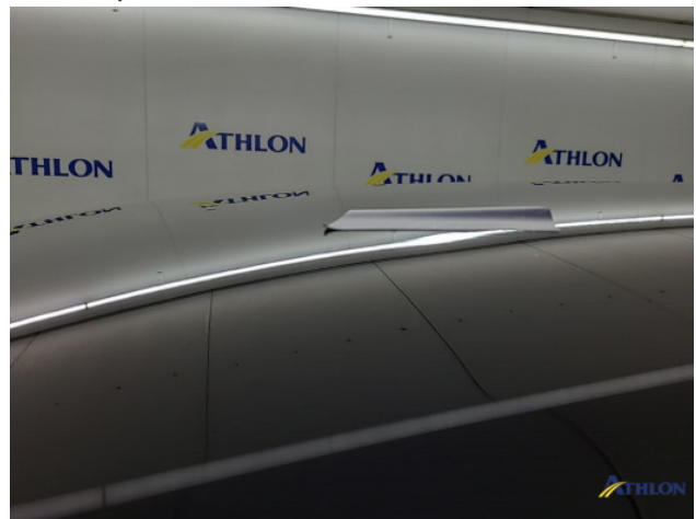
1. diverse schades Gebruikssporen
