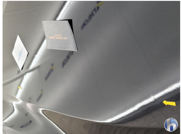
3. slecht herstel Gebruikssporen - Aanvaardbaar
