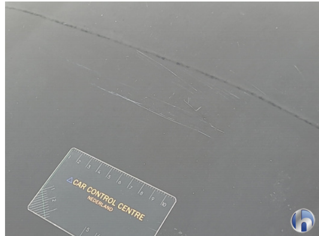
1. Dak Krassen - Spuiten
