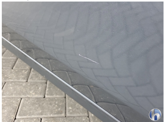
1. Diverse Gebruikssporen - Aanvaardbaar
