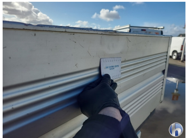
5. Achterklep Deuk/deuken - Herstellen
