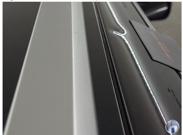
1. Dak Hagelschade - Herstellen zonder spuiten
