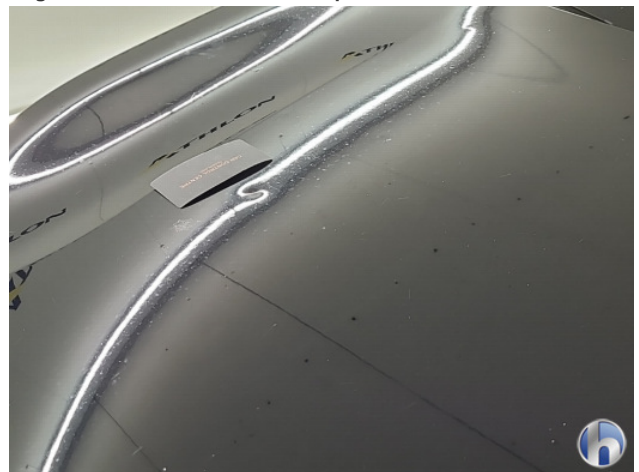
1. Dak Hagelschade - Herstellen zonder spuiten
