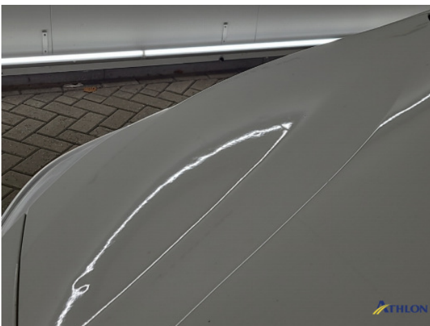
1. hagelschade dak Deuk/deuken
