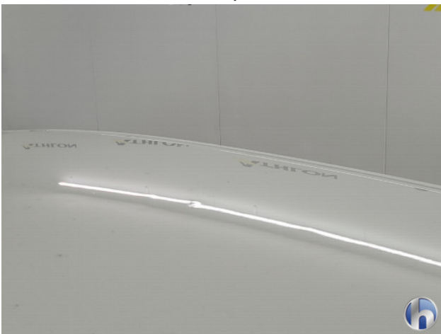
1. hagelschade dak Deuk/deuken - Herstellen zonder spuiten
