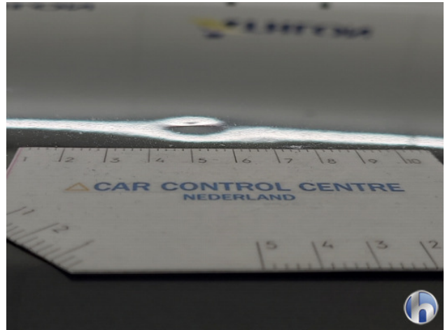
1. Dak Hagelschade - Herstellen
