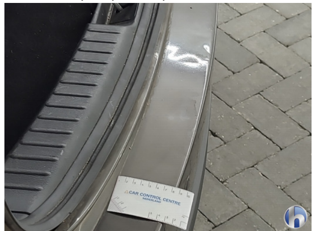
2. Achterbumper Deuk/deuken - Spot Repair/Deelreparatie
