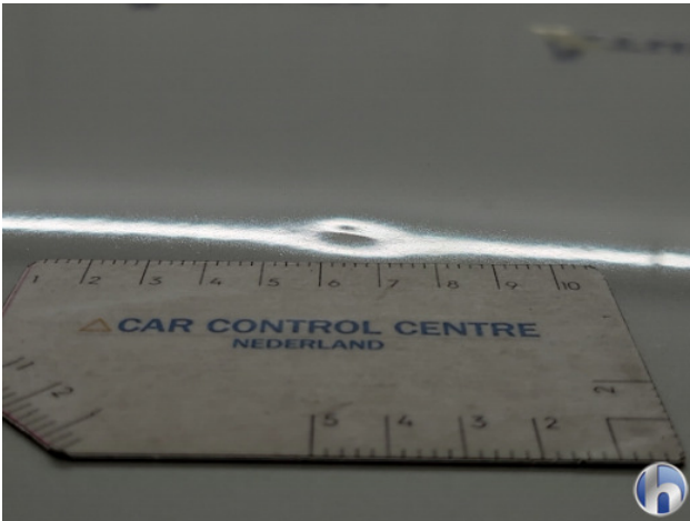
1. Dak Gebruikssporen - Aanvaardbaar
