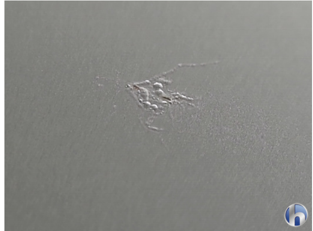
4. lakaantasting Beschadigd - Spuiten
