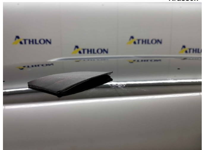
3. Ingevreten vogelpoep MK, dak
