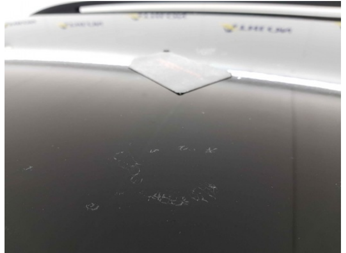
11. Ingevreten vogelpoep dak
