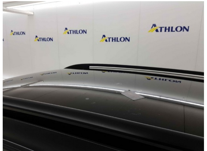
11. Ingevreten vogelpoep dak
