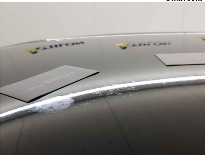
7. Ingebrande vogelpoep dak
