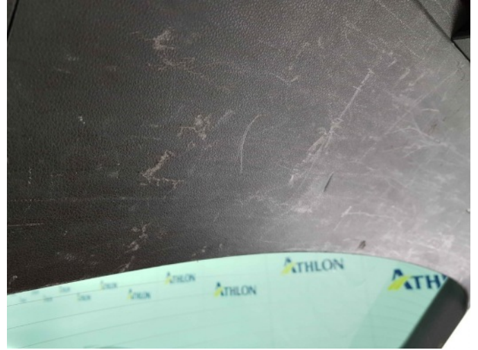
4. Diverse interieur schade
