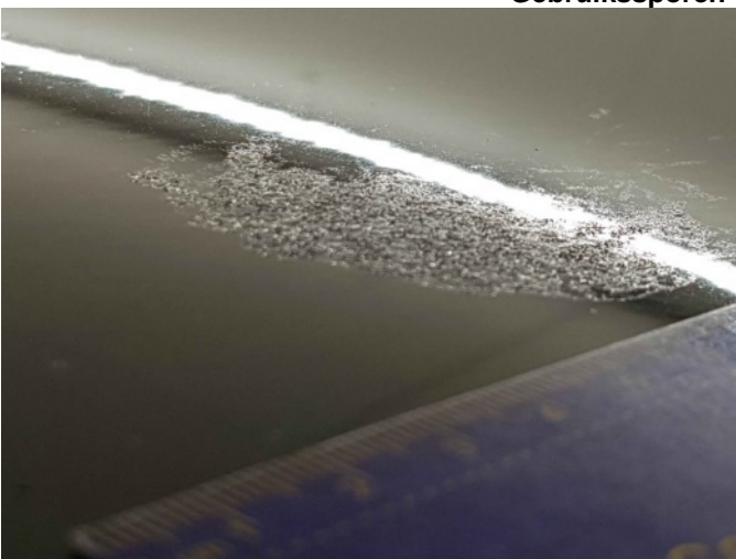
3. Dak ingebrande vogelpoep
