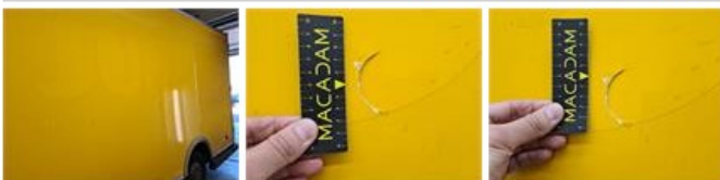
Achterdeur R bekleding, Barst, Vervangen
