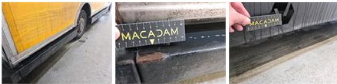
Wielkuip bekleding A L, Kras(sen), Vervangen
